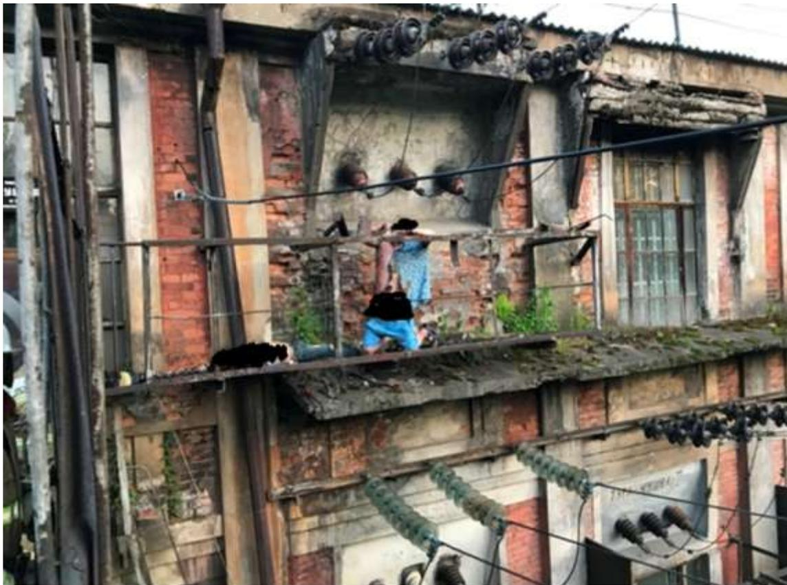
Групповой несчастный случай. Пострадавшие, путем обхода заваренной двери по металлоконструкциям, расположенным на высоте 3-го этажа, перелезли с канатного подвесного моста на площадку обслуживания проходных изоляторов ВЛ 35 кВ, приблизившись на недопустимое расстояние к токоведущим частям на расстояние менее допустимого и попали под напряжение
